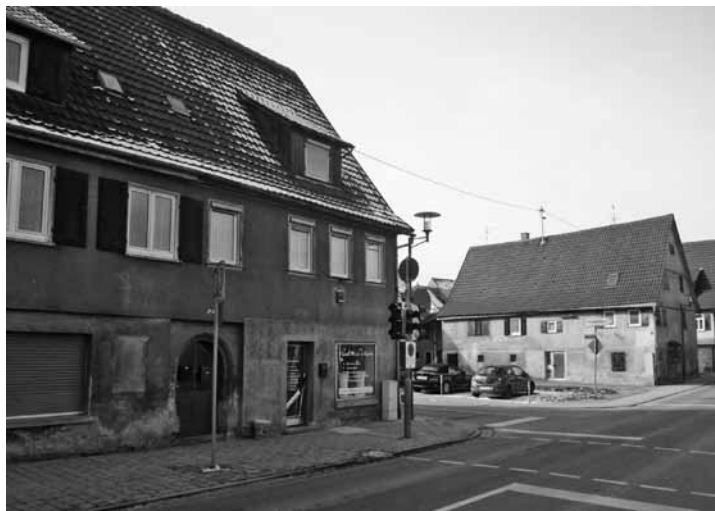
Die Sielminger Hauptstraße ist Sanierungsbedürftig
