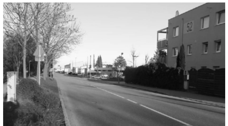
Die Karlstraße wird im Zuge der S-Bahn-Verlängerung umgebaut
